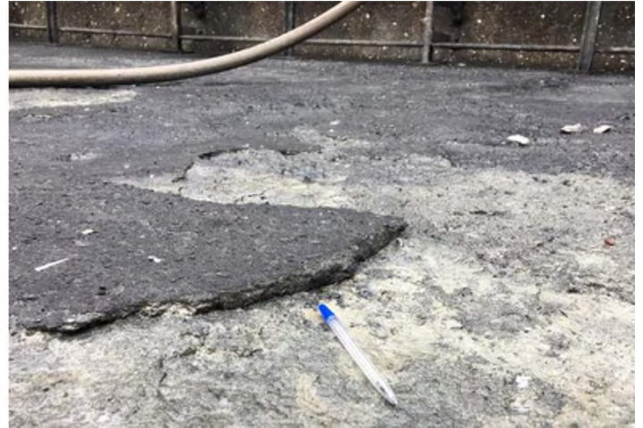
Sanierung und Abdichtung des Tanks
