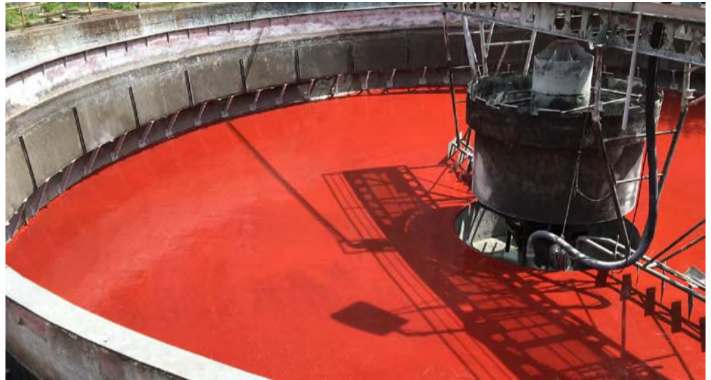
Sanierung und Abdichtung des Tanks
