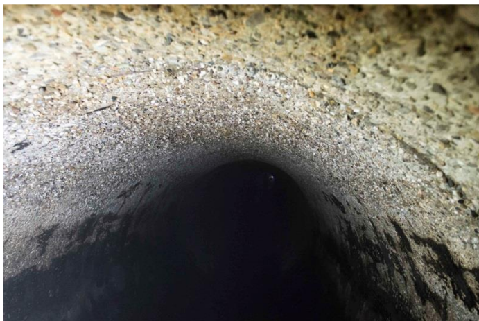
Onze referentie in Breda (Nederland): Betonreparatie influentleiding
