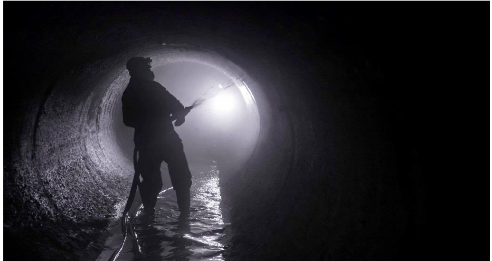
Onze referentie in Breda (Nederland): Betonreparatie influentleiding
