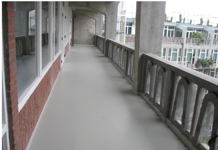
Onze referentie in Rotterdam (Nederland): renovatie galerijvloeren
