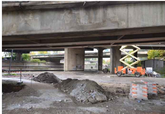
Onze referentie in Charleroi (België): Viaduct Charleroi
