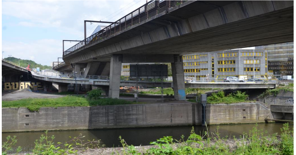
Onze referentie in Charleroi (België): Viaduct Charleroi
