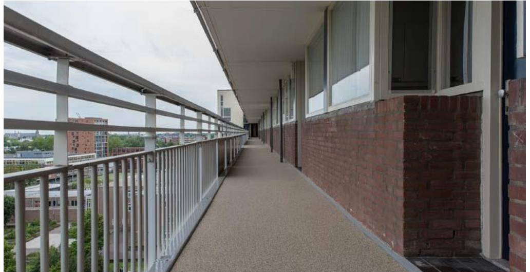
Onze referentie in Gouda (Nederland): Renovatie galerijvloeren
