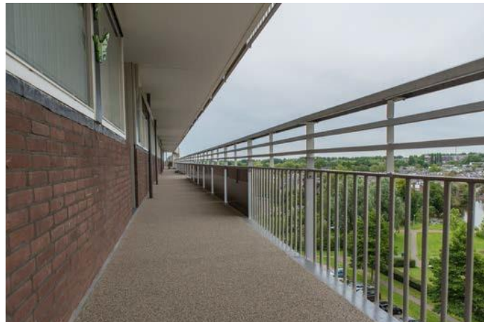
Onze referentie in Gouda (Nederland): Renovatie galerijvloeren
