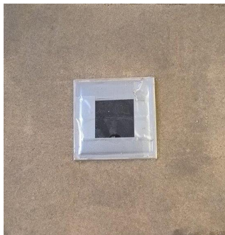
Efter: Afløbet er omstøbt med epoxymørtel af MasterTop P 621 tilsat kvartssand.
