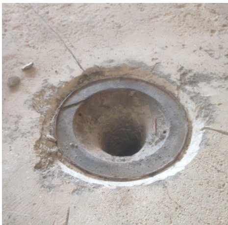
Før: De gamle afløb måtte udskiftes.
