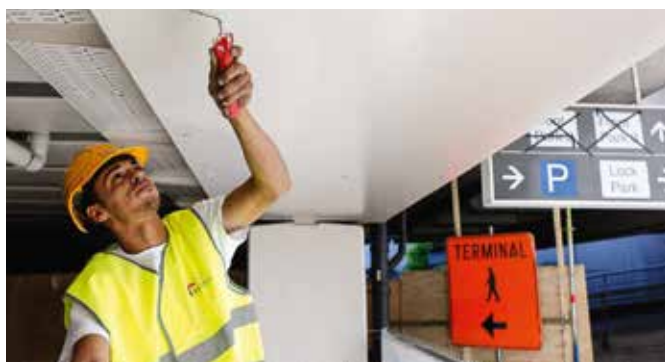
Manuell påføring av MasterProtect 330 EL (Parkeringsanlegg, Brussel lufthavn, Belgia)
