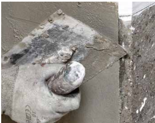
Avretting av overflate med MasterEmaco N 5100 FC
